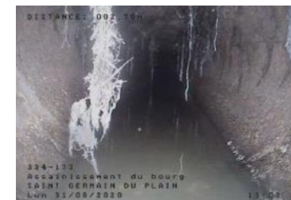
Racines et hauteur d'eau dans la canalisation
