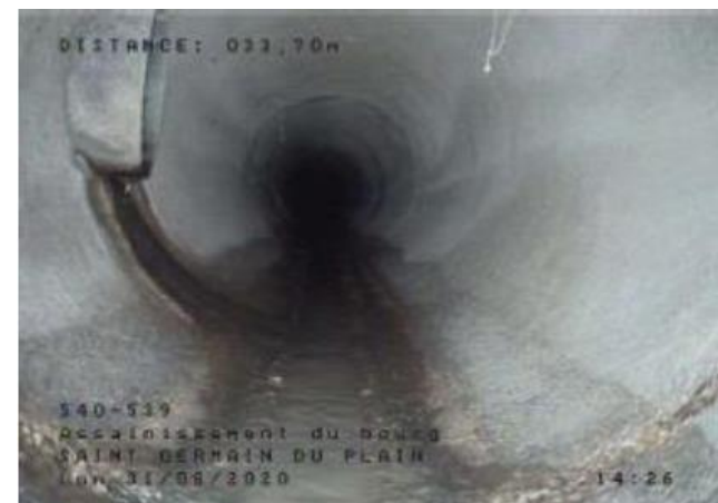
Passage caméra – infiltration observée
