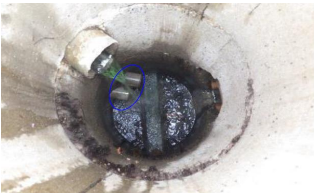
Raccordement d'eaux pluviales au réseau d'eaux usées
