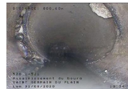
Déplacement d'assemblage
