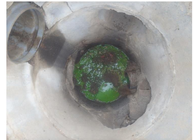
R1026 – arrivées des réseaux d’eaux pluviales stricts raccordés rue des Tilles/Angles
