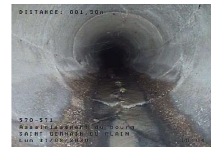
Rupture de la canalisation
